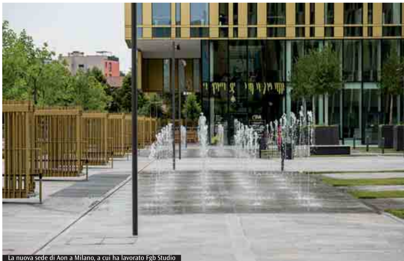
La nuova sede di Aon a Milano, a cui ha lavorato Fgb Studio
